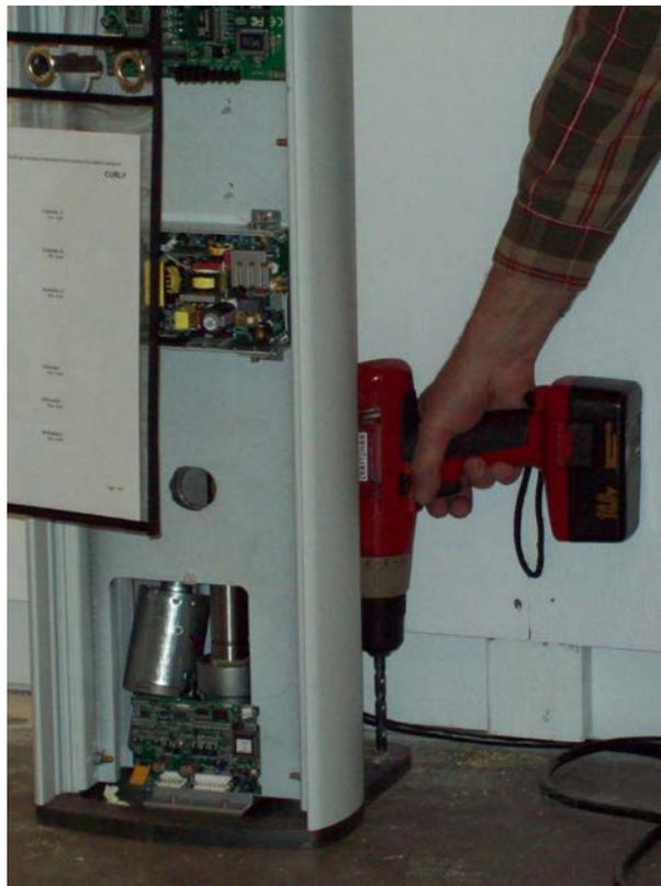
3. 1 Zementankerschraube durch die Öffnung an der Platte in das Bohrloch einsetzen. 1 Unterlegscheibe und 1 Mutter auf die Zementankerschraube auflegen und anziehen. Darauf achten, dass die Ankerschraube vollständig in das Bohrloch eingeschraubt wird. Bei Holzboden 1 Unterlegscheibe auf 1 Ankerschraube auflegen und die Ankerschraube in die Öffnung an der Platte einsetzen. Die Ankerschraube mit einem Steckschlüssel ein Stück anziehen.
